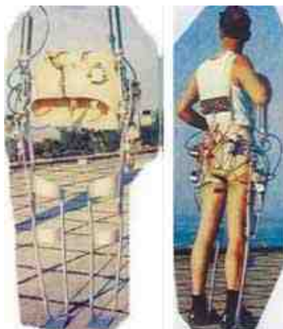
Рис. 8.17. Первый в мире шагающий активный экзоскелет на пневматическом приводе с частично запрограммированной кинематикой для воспроизведения походки, близкой к человеческой, сделан в 1969 г. в институте им. Михаила Пупина и является предшественником более сложных экзоскелетных устройств для инвалидов
